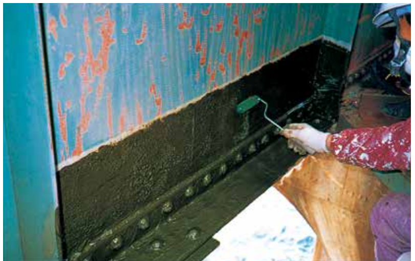
橋桁下部の補強塗装
