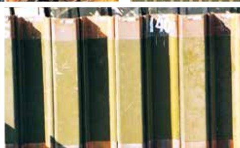
工場でスプレー塗装した新設鋼矢板
