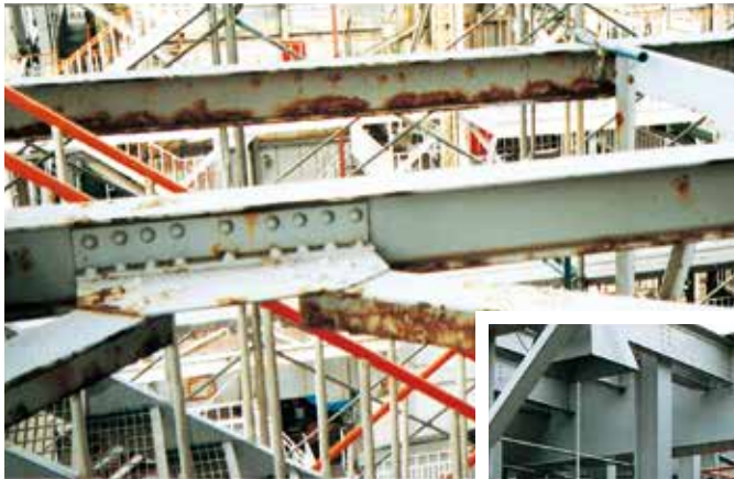
ボイラー鉄骨
