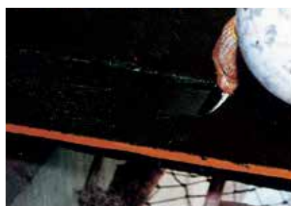
孔食部の補修（強食部）
