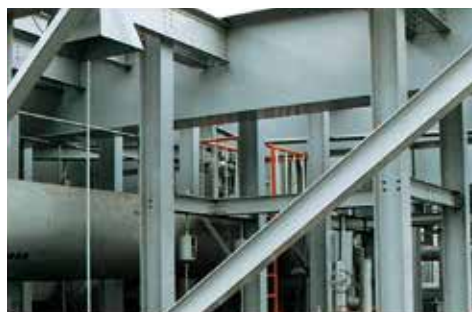
腐食部の補強塗装
