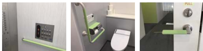
エレベーター内の補助手すりに
