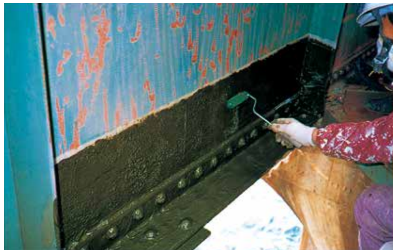
橋桁下部の補強塗装
