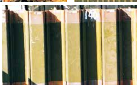
工場でスプレー塗装した新設鋼矢板
