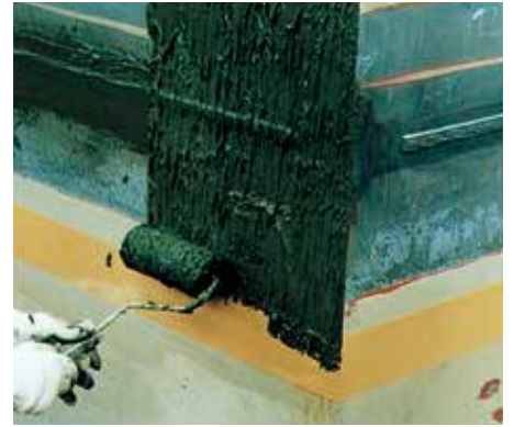
現地継手部の補強塗装
