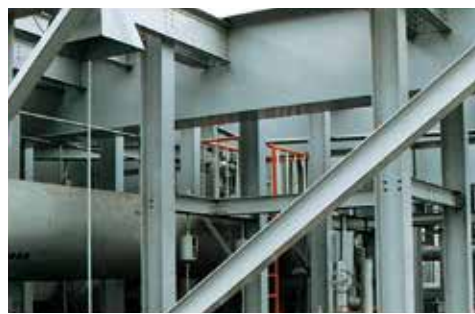
腐食部の補強塗装
