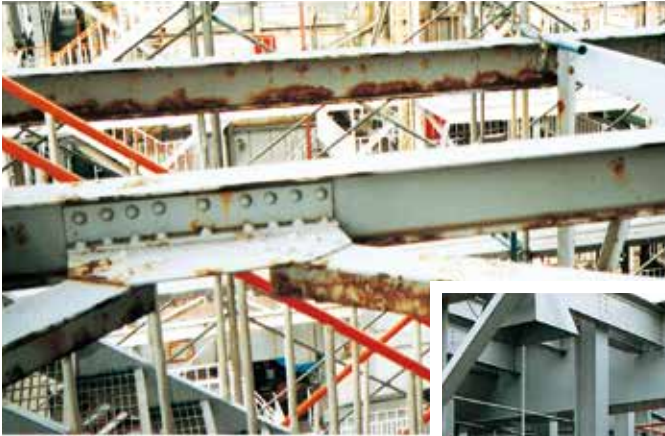
ボイラー鉄骨
