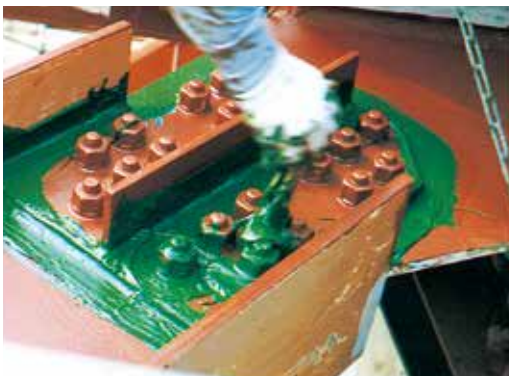
ナブコバリアー5M補強中 ボルト継手部の補強塗装
