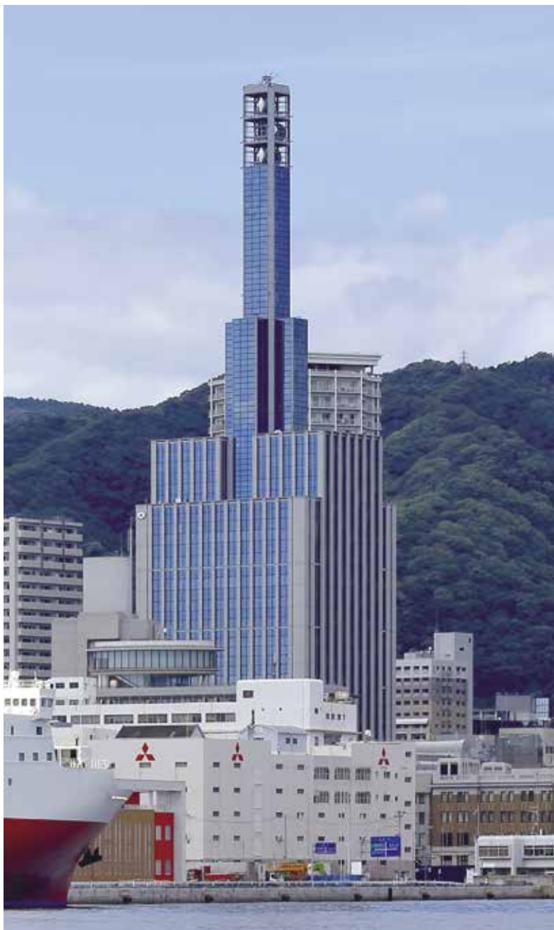
神戸関電ビル
