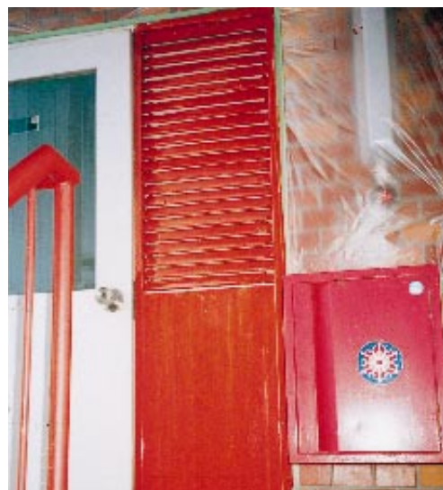
写真5 「ザウルスEX」の施工事例
