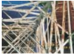
写真1 塗替前の送電鉄塔
