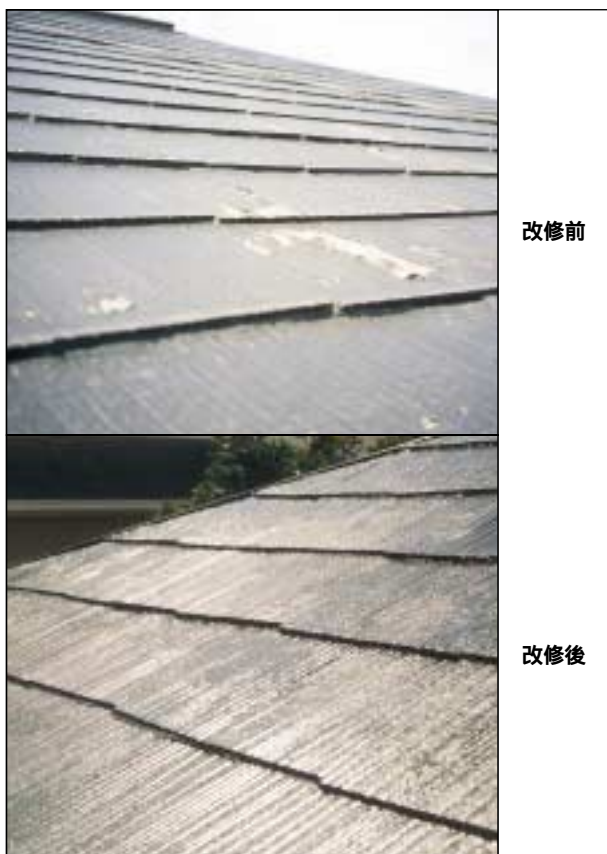
写真4 「シリコン防水コーティング工法」施工例
