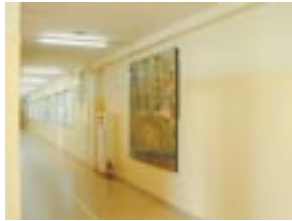
写真4-3 改修後の1階廊下
