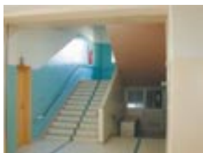
写真6-3 改修後の階段(東側)
