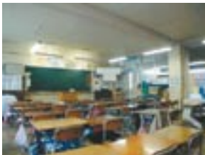
写真5-1 改修前の教室
