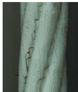
写真3 ハンガーロープの腐食事例
