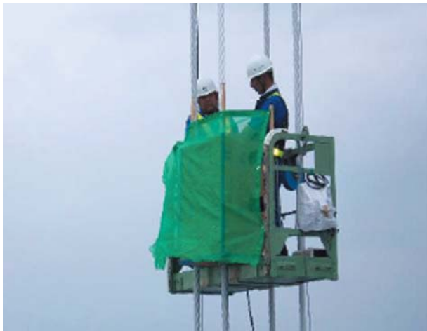
写真7 吊り橋での塗装試験状況
