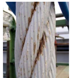
写真3 ハンガーロープの腐食事例
