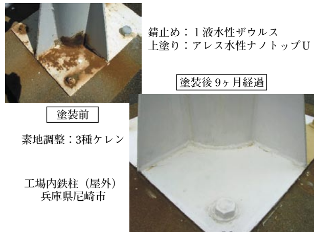
図11 屋外鉄部における施工例
