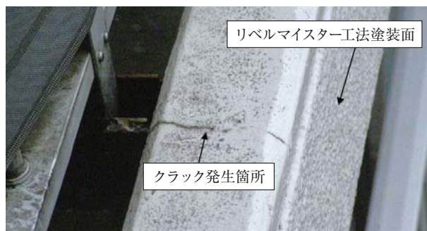
写真2 「リベルマイスター工法」で塗装した見付部の塗膜状態（神奈川県内集合住宅B）
