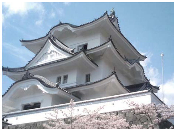
写真4 「アレシッコイ外部用」施工例(伊賀上野城天守閣(三重県))
